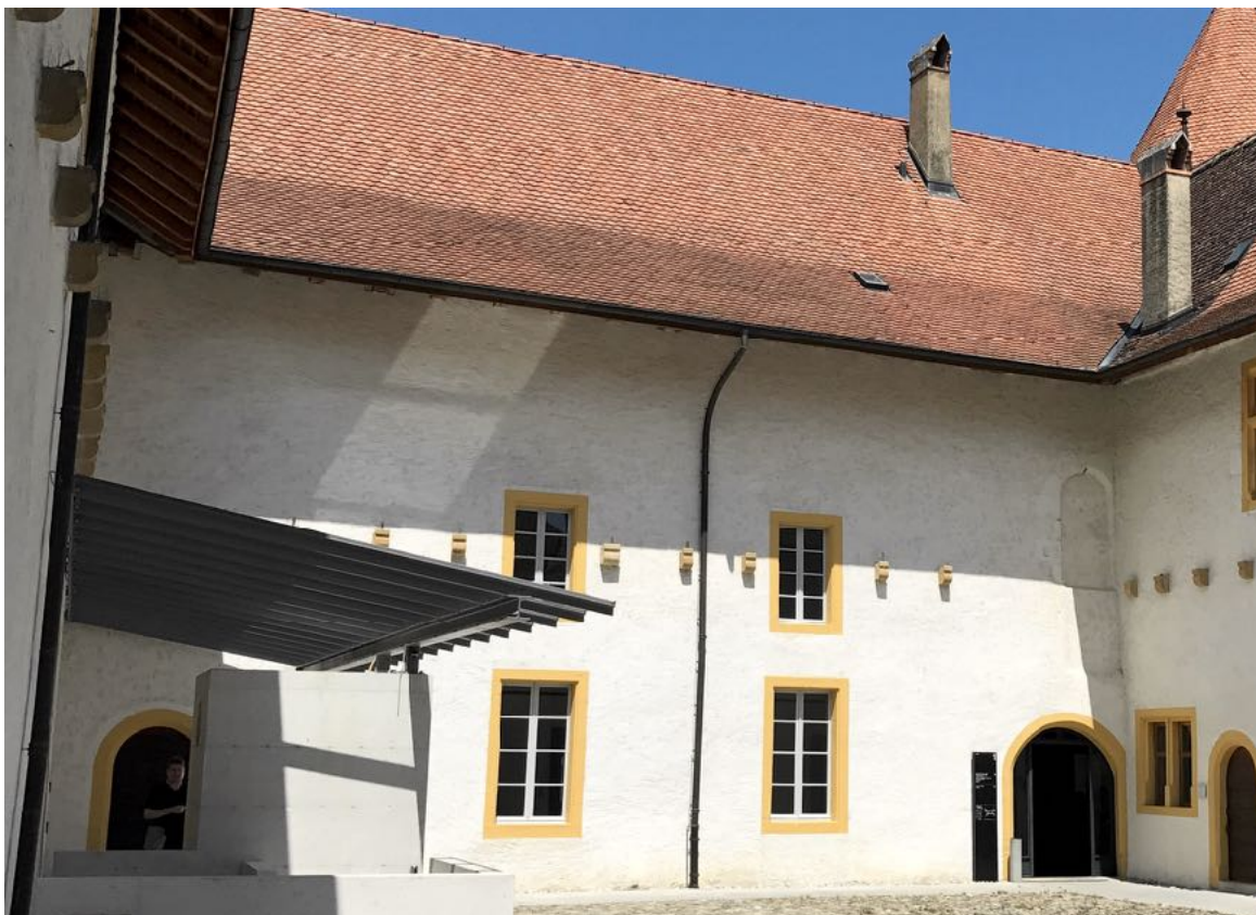
en haut : façade Nord sur cour, corps E état en 2017
