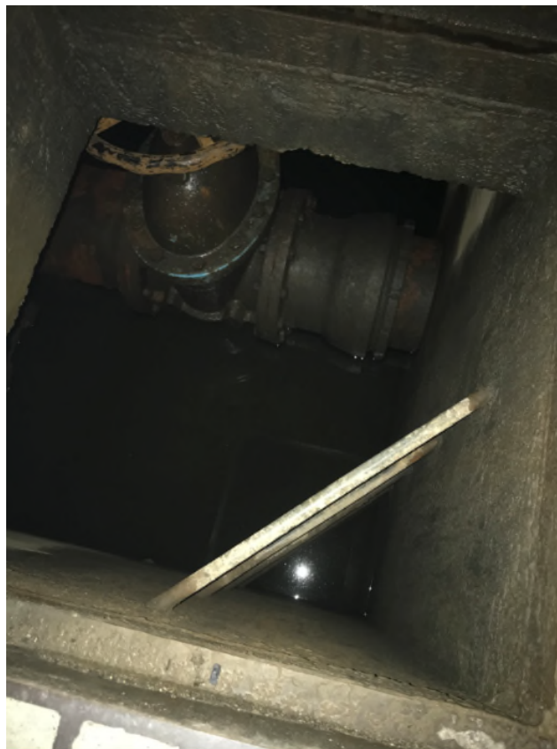
Une chambre partiellement inondée
